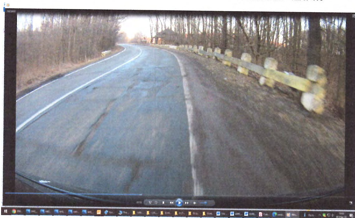
Zona de drum DN29A, zona km 32+000, degradari la nivelul imbracamintii rutiere pe suprafete extinse , gropi, faientari, cu fisuri si crapaturi pe mai multe directii, pelada, parapet rigid degradat
