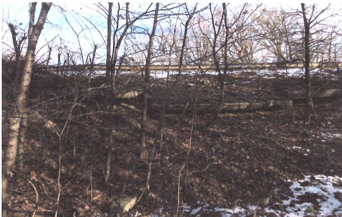
Zona de drum DN29A, zona km 29+900, cu zona de dale de beton pe partea stanga prabusite datorita surparilor produse la corpul terasamentelor, se vor stabili solutii de consolidare conform recomandarilor din studiul geotehnic si solutiilor stabilite de expertiza la cerinta Af
