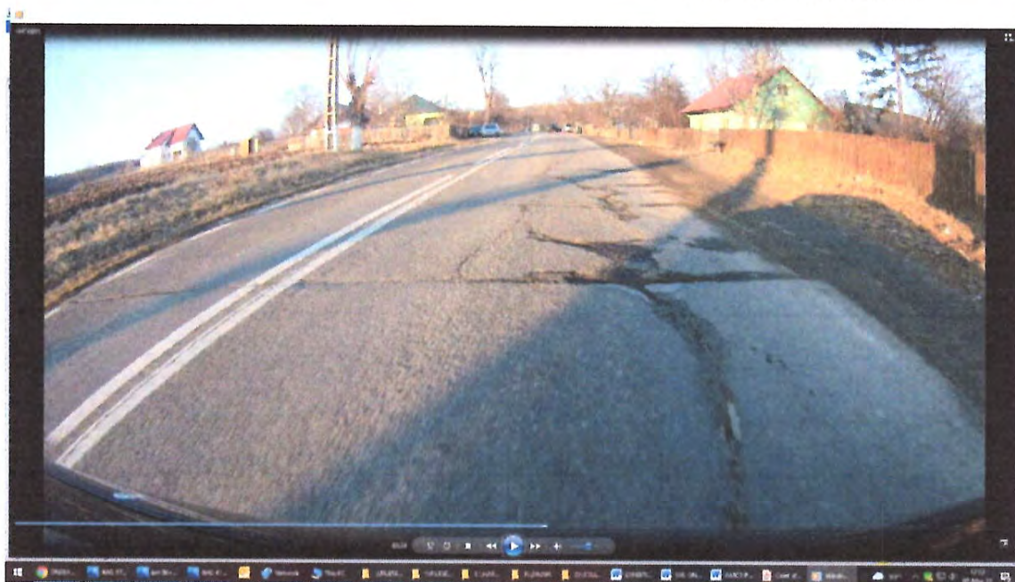
Zona de drum DN29A , cu degradari la nivelul imbracamintii rutiere , cu gropi, faiantari , cu fisuri si crapaturi pe mai multe directii,dale din beton sparte, fara santuri de scurgere
