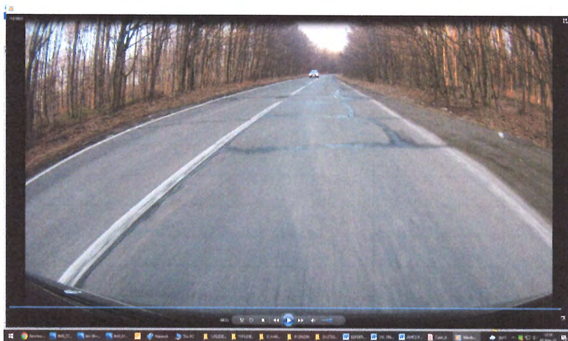
Zona de drum DN29A , cu degradari la nivelul imbracamintii rutiere , cu fisuri si crapaturi pe mai multe directii,dale din beton sparte, acostamente degradate, santuri lipsa
