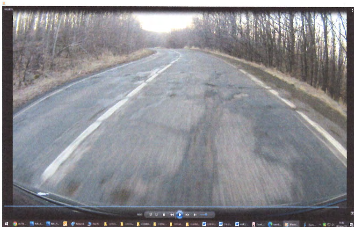
Zona de drum DN29A, cu degradari la nivelul imbracamintii rutiere pe suprafete extinse , gropi, cu fisuri si crapaturi pe mai multe directii, pelada, acostamente degradate, fara santuri
