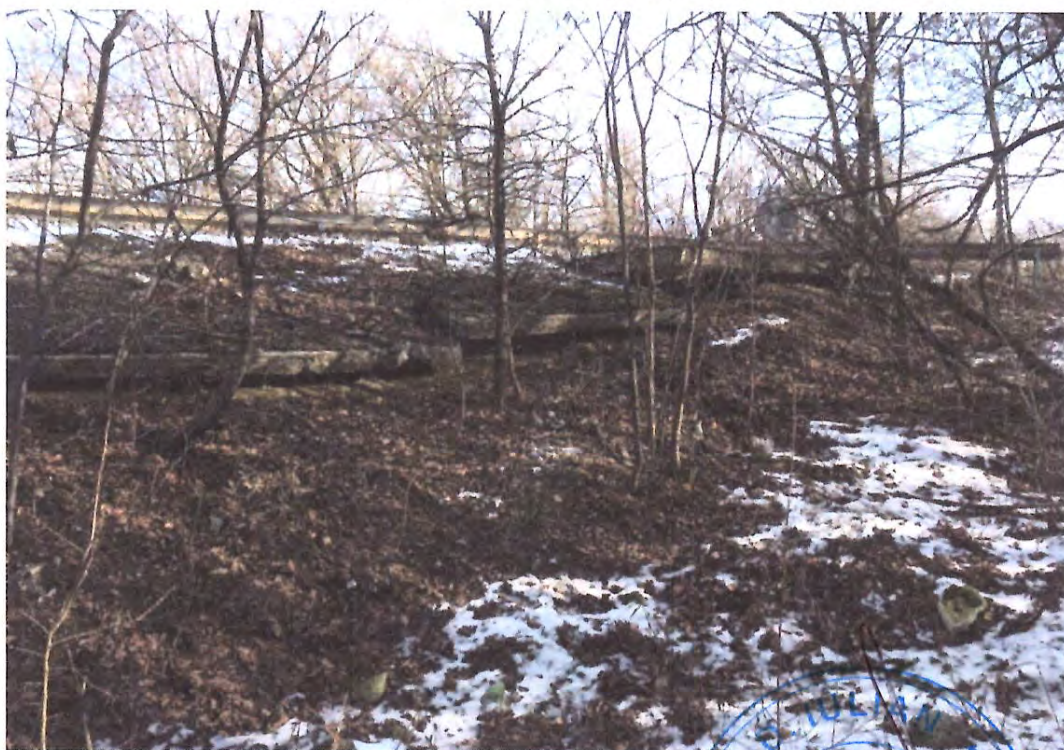
Zona de drum DN29A, zona km 29+900, cu zona de dale de beton pe partea stanga prabusite datorita surparilor produse la corpul terasamentelor, se vor stabili solutii de consolidare conform recomandarilor din studiul geotehnic si solutiilor stabilite de expertiza la cerinta Af
