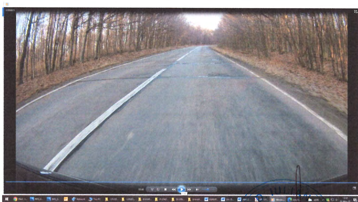
Zona de drum DN29A , cu degradari la nivelul imbracamintii rutiere , cu fisuri si crapaturi pe mai multe directii,dale din beton sparte, acostamente degradate, santuri lipsa
