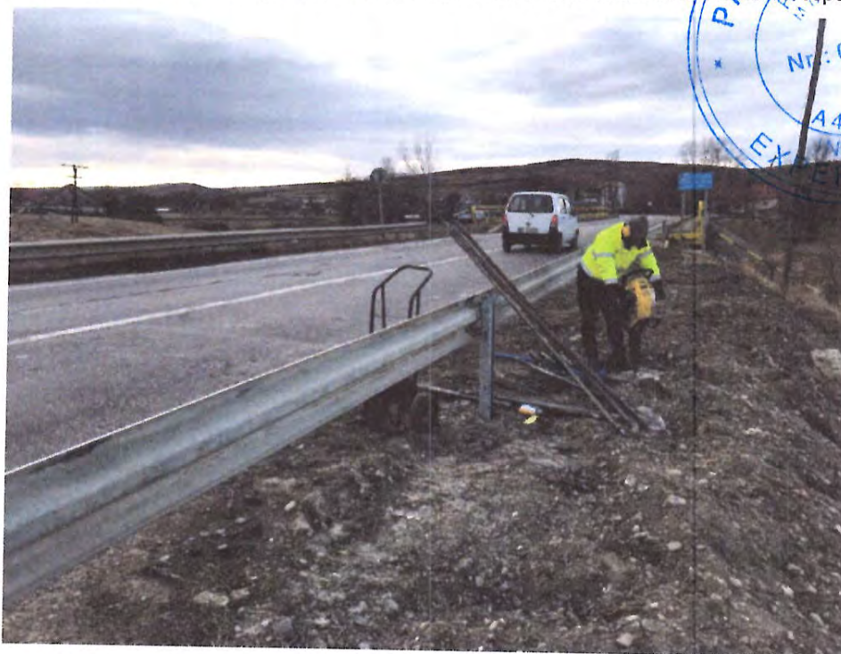
Umputuri refacute in zona rampei podului, fara o compactare corespunzatoare
