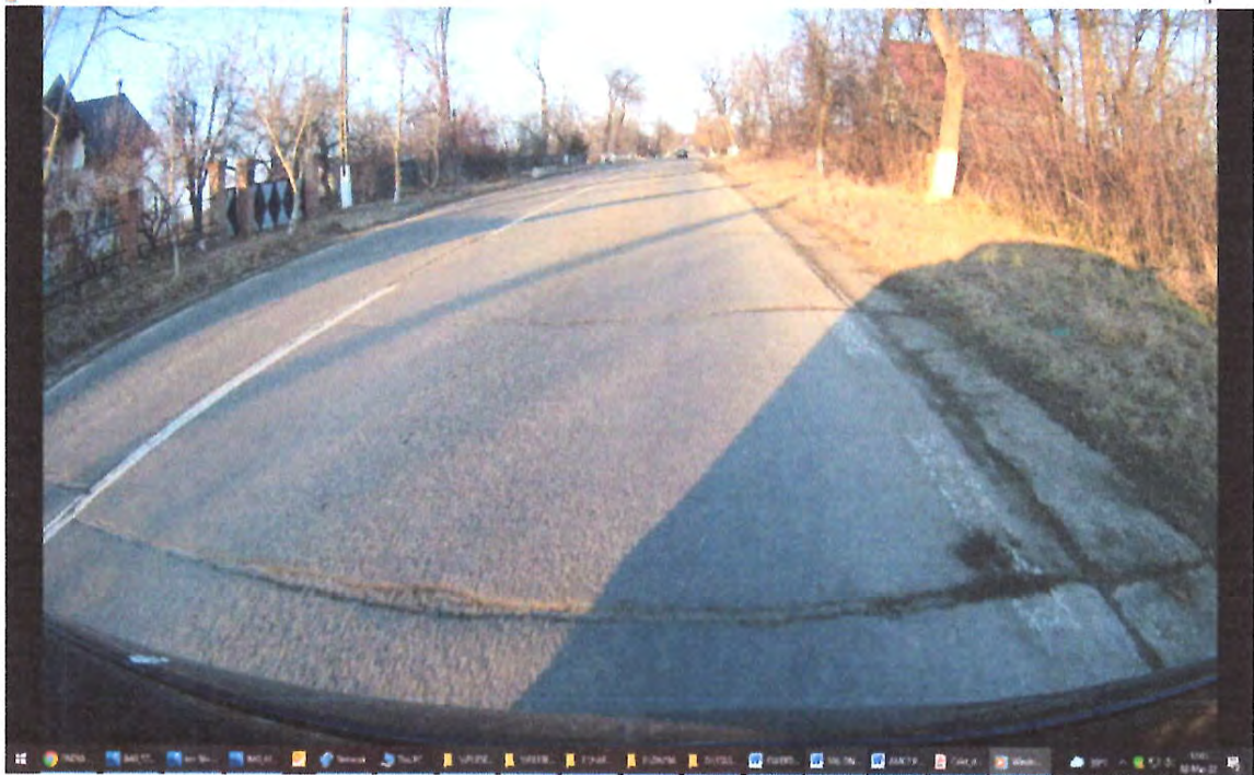
Zona de drum DN29A,, cu degradari la nivelul imbracamintii rutiere,gropi, faiantari, cu fisuri si crapaturi pe mai multe directii, lipsa santuri,
