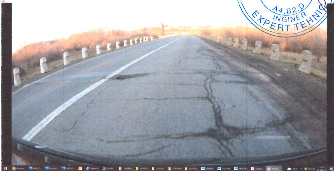
Zona de drum DN29A, sector de inceput cu degradari la nivelul imbracamintii rutiere, cu fisuri si crapaturi pe mai multe directii, parapet rigid degradat
