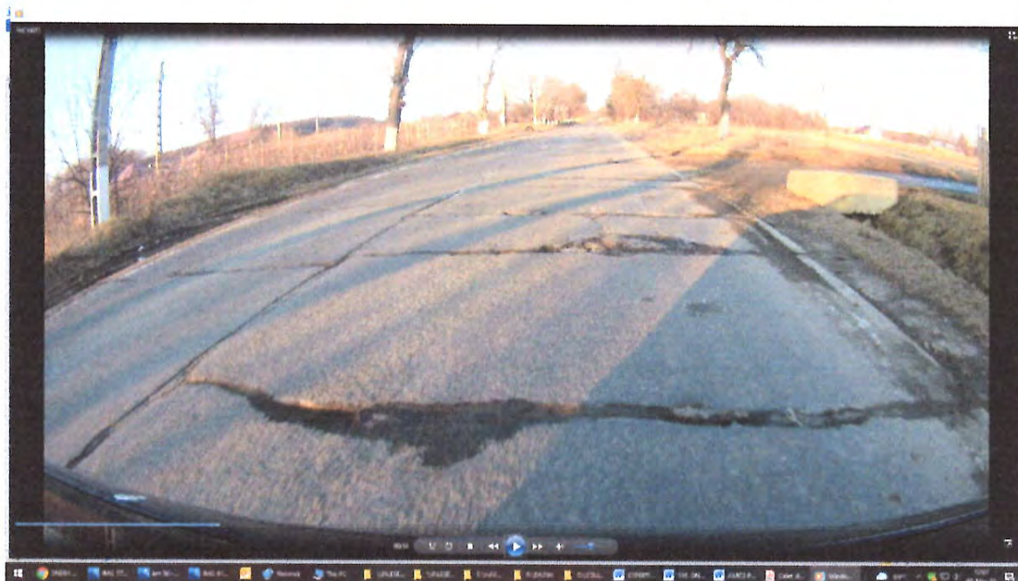
Zona de drum DN29A km 25+000,, cu degradari la nivelul imbracamintii rutiere , cu gropi, faiantari, cu fisuri si crapaturi pe mai multe directii, santuri din pamant colmatate
