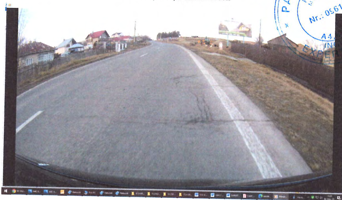
Zona de drum DN29A, zona km 37+000, cu degradari la nivelul imbracamintii rutiere pe suprafete extinse , gropi, zone cu fisuri si crapaturi pe diverse directii
