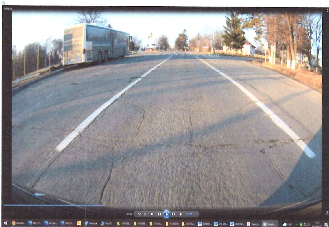
Zona de drum DN29A, sector de inceput cu degradari la nivelul imbracamintii rutiere, gropi, cu fisuri si crapaturi pe mai multe directii
