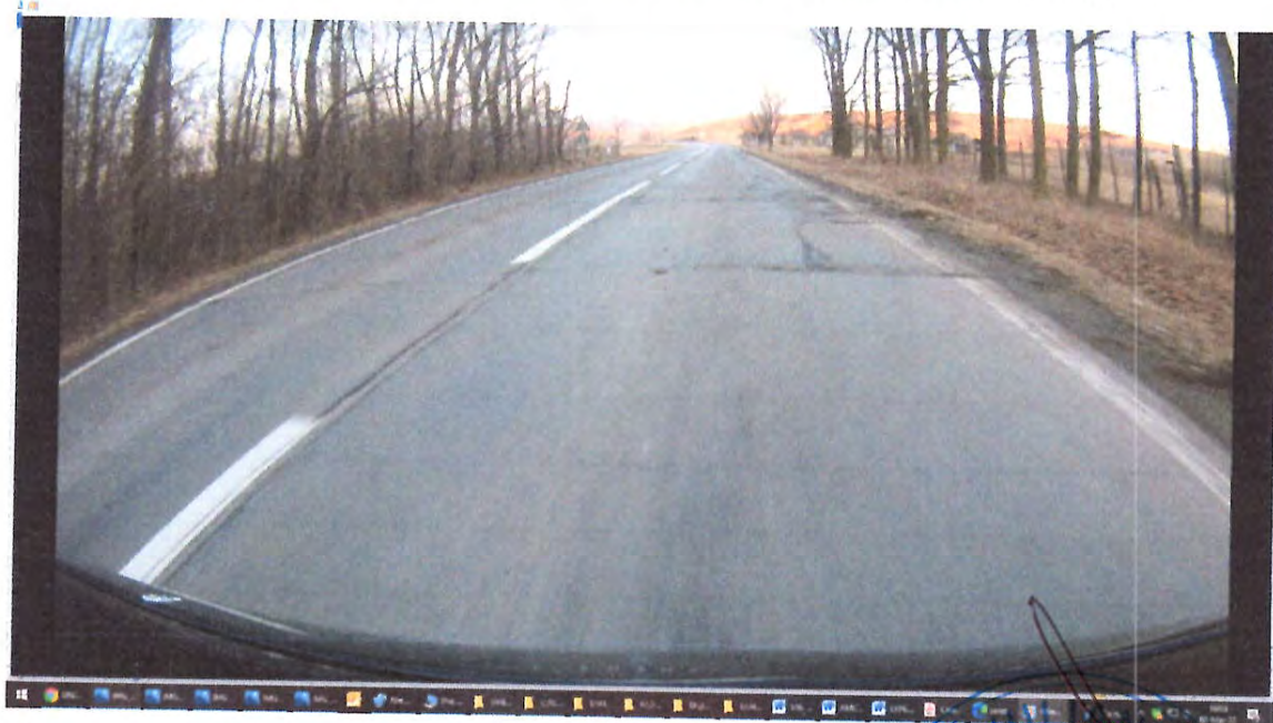
Zona de drum DN29A, zona km 32+500, degradari la nivelul imbracamintii rutiere pe suprafete extinse , gropi, faientari, cu fisuri si crapaturi pe mai multe directii, pelada, sant din pamant colmatat
