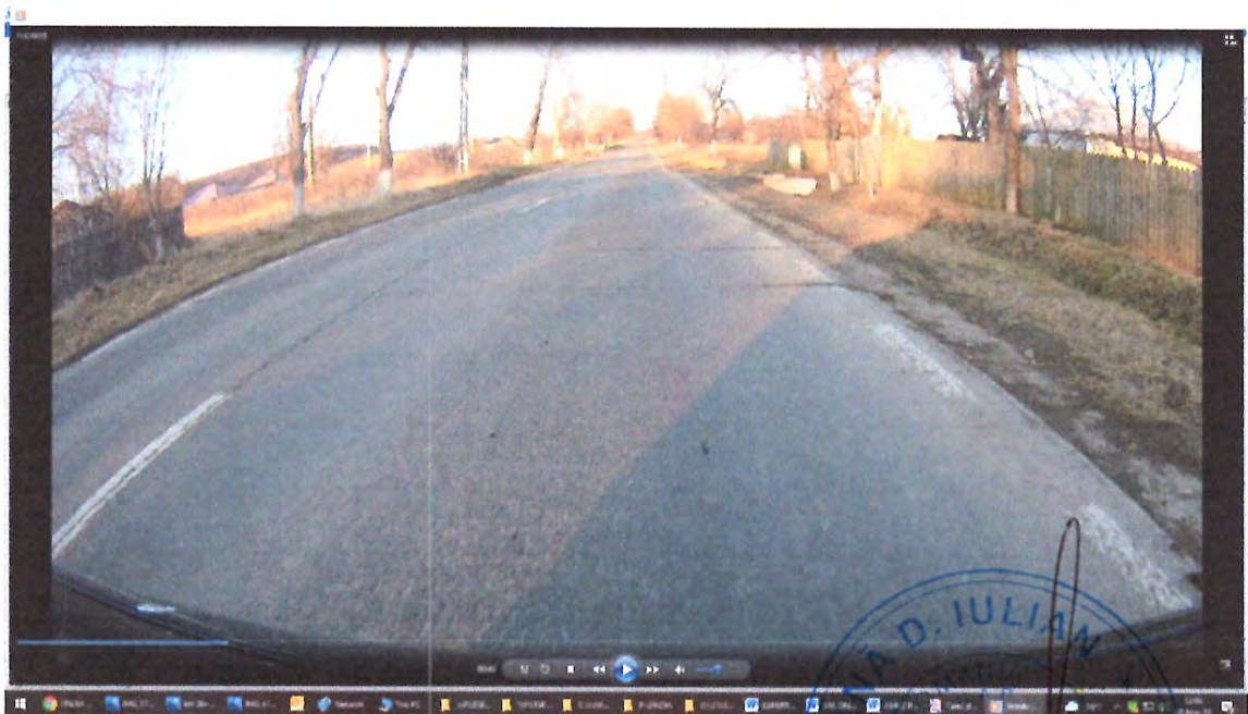
Zona de drum DN29A km 25+000,, cu degradari la nivelul imbracamintii rutiere , faiantari, cu fisuri si crapaturi pe mai multe directii, santuri din pamant colmate
