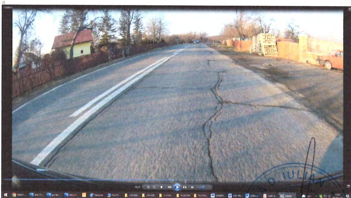
Zona de drum DN29A,, cu degradari la nivelul imbracamintii rutiere, gropi, faiantari, cu fisuri si crapaturi pe mai multe directii, lipsa santuri, apa balteste pe acostamente
