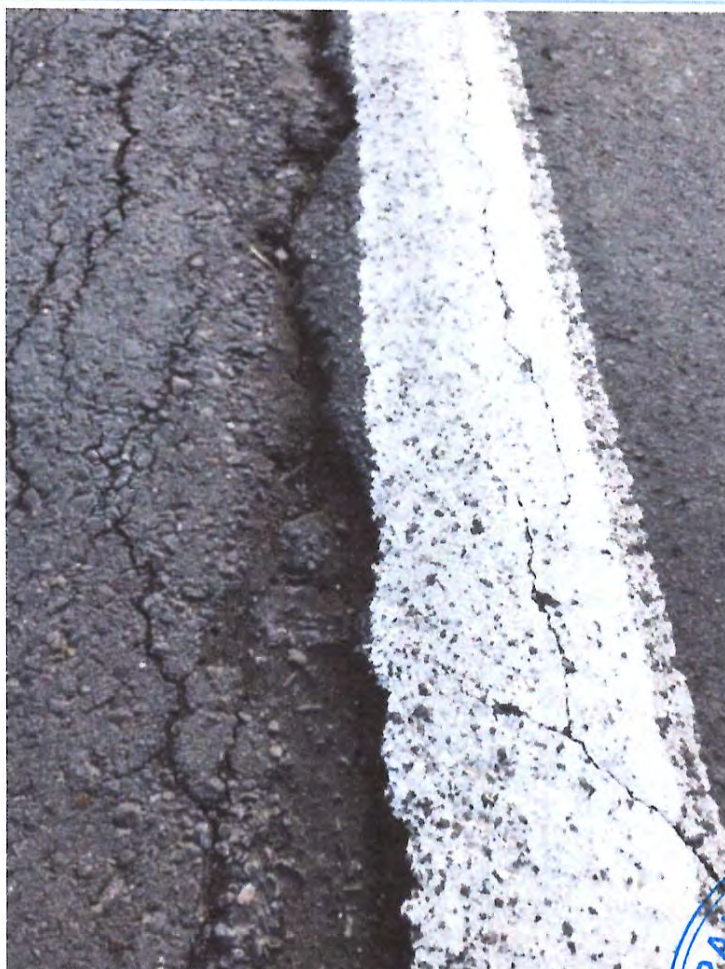
Uzura accentuată a structurii rutiere;
