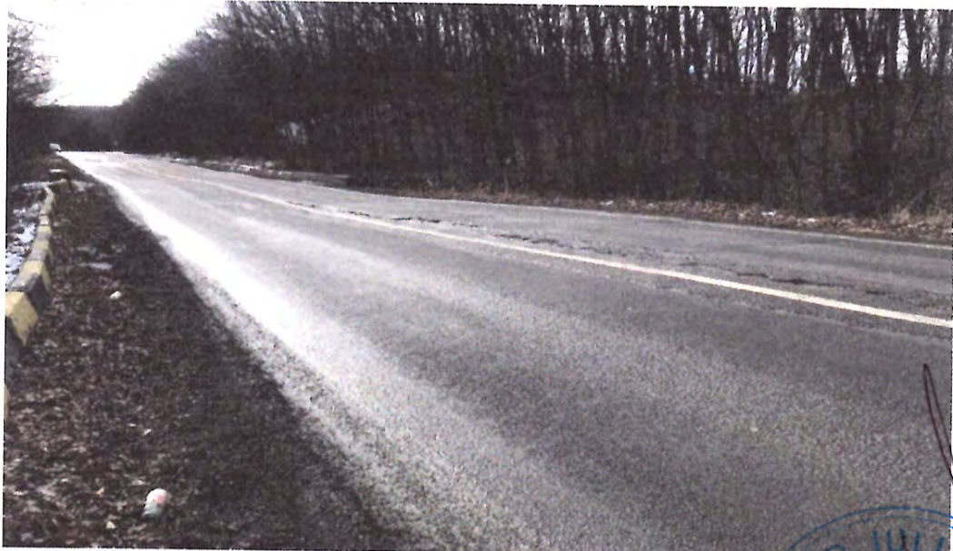
Zona de drum DN29A, degradari la nivelul imbracamintii rutiere pe suprafete extinse , gropi, faiantari, cu fisuri si crapaturi pe mai multe directii, denivelari, pelada, cu denivelari longitudinale si tasari ale dalelor
