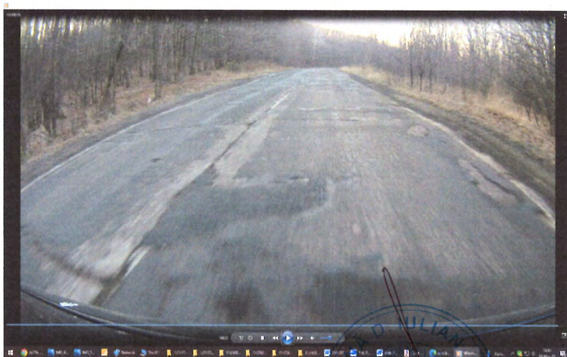
Zona de drum DN29A, cu degradari la nivelul imbracamintii rutiere pe suprafete extinse , gropi, falantari, cu fisuri si crapaturi pe mai multe directii, pelada, acostamente degradate, fara santuri
