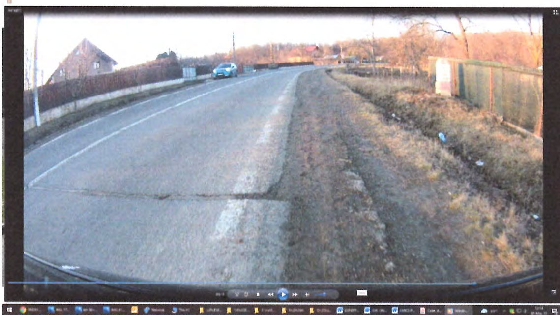
Zona de drum DN29A ,km 26+000 cu degradari la nivelul imbracamintii rutiere , cu gropi, faiantari, cu fisuri si crapaturi in zona rosturilor , santuri din pamant colmate
