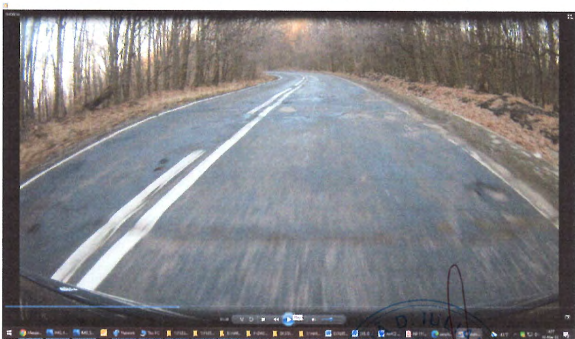
Zona de drum DN29A , cu degradari la nivelul imbracamintii rutiere pe suprafete extinse , gropi, cu fisuri si crapaturi pe mai multe directii, , acostamente degradate, santuri pereate colmate*
