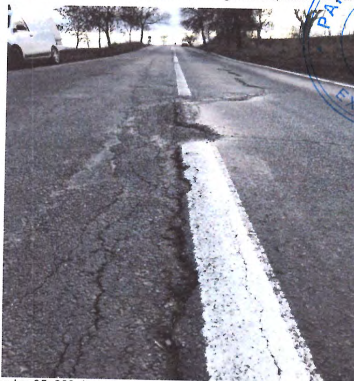
Zona de drum DN29A, zona km 35+200 degradari la nivelul imbracamintii rutiere pe suprafete extinse , gropi, fisuri si crapaturi, crapatura longitudinala , denivelari longitudinale, tasari ale partii carosabile
