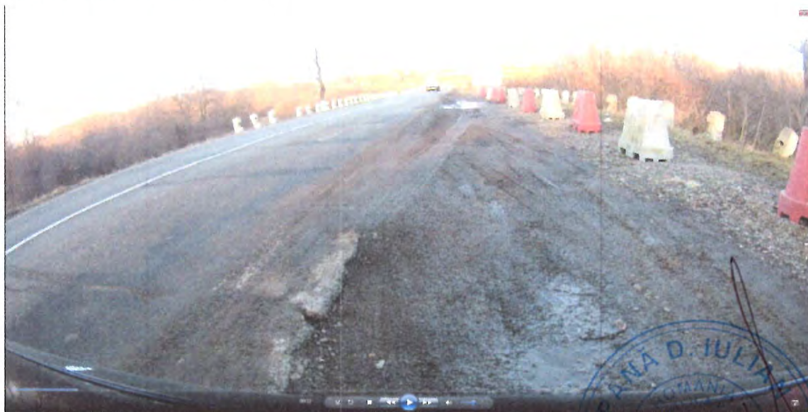
Zona de drum DN29A, sector de inceput cu degradari la nivelul imbracamintii rutiere, ruperi la margine, crapaturi si fisuri
