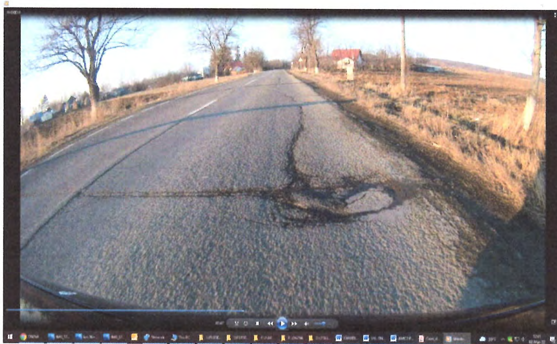
Zona de drum DN29A, km 24+000, cu degradari la nivelul imbracamintii rutiere, gropi, faiantari, cu fisuri si crapaturi pe mai multe directii, lipsa santuri
