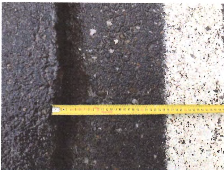
Crăpături adânci în structura rutieră;
