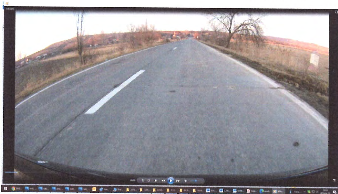
Zona de drum DN29A, zona km 33+000, degradari la nivelul imbracamintii rutiere pe suprafete extinse , cu fisuri si crapaturi pe zona rosturilor transversale si longitudinale
