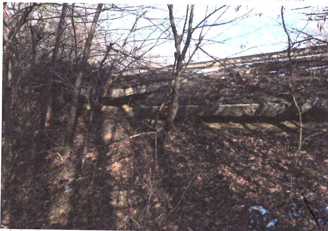
Zona de drum DN29A, zona km 29+950, cu zona de dale de beton pe partea stanga prabusite datorita surparilor produse la corpul terasamentelor, se vor stabili solutii de consolidare conform recomandarilor din studiul geotehnic si solutiilor stabilite de expertiza la cerinta Af
