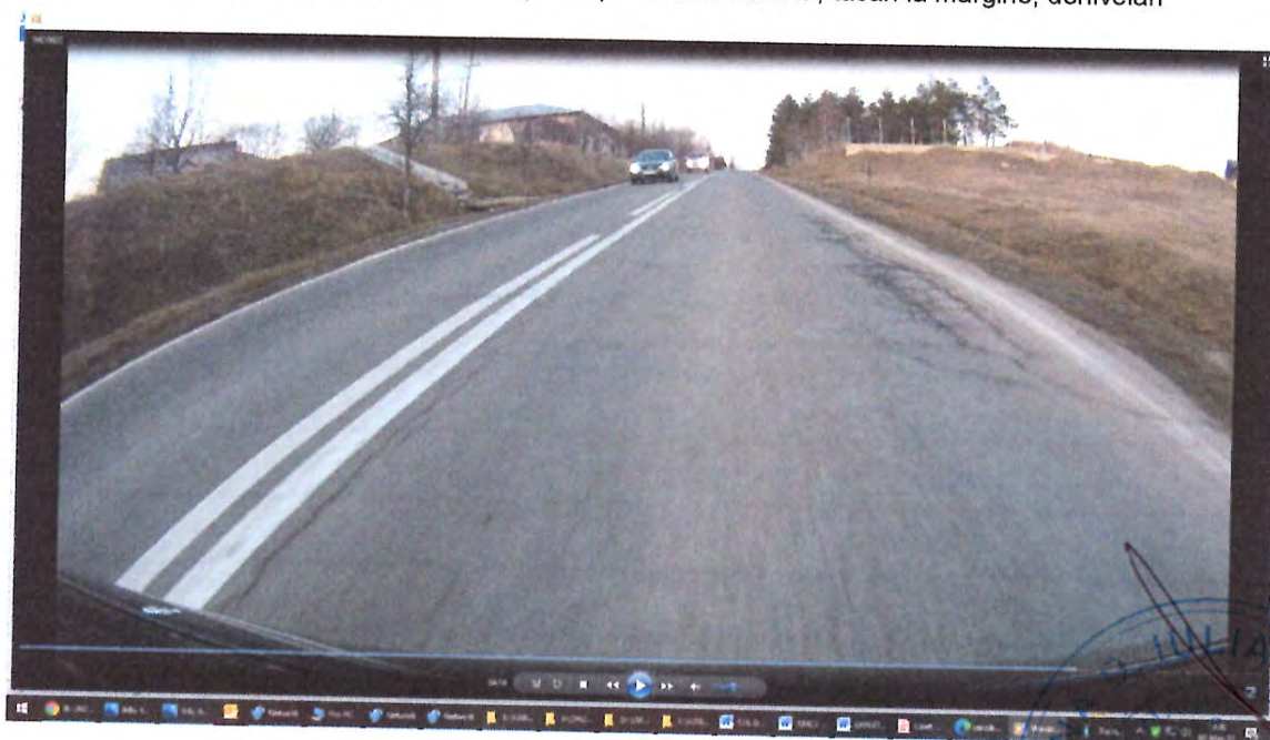
Zona de drum DN29A, zona km 37+300, cu degradari la nivelul imbracamintii rutiere pe suprafete extinse , gropi, zone cu fisuri si crapaturi pe diverse directii , fiantari, tasari la margine, denivelari, sant degradat
