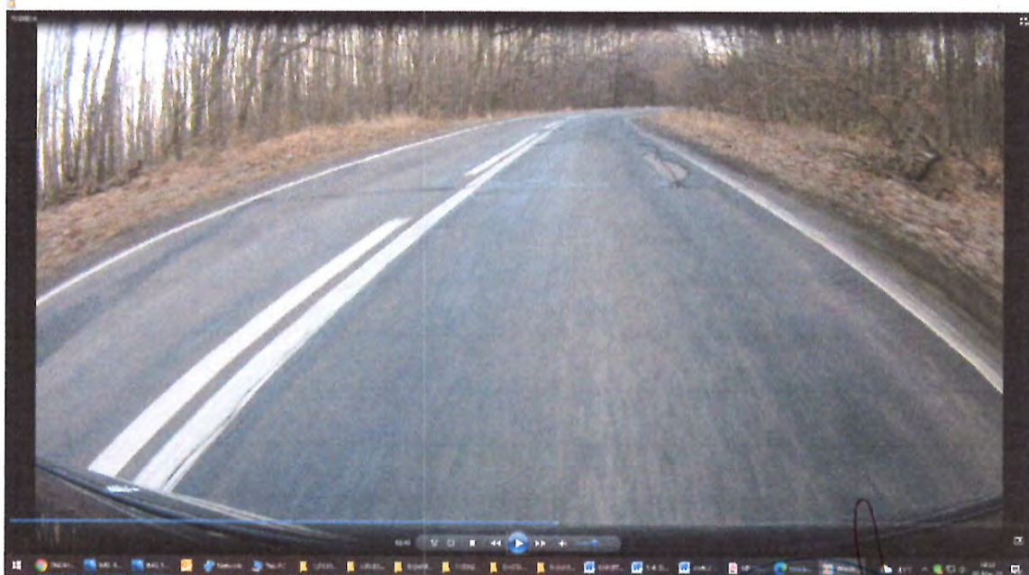
Zona de drum DN29A, cu degradari la nivelul imbracamintii rutiere pe suprafete extinse , gropi, cu fisuri si crapaturi pe mai multe directii, , acostamente degradate, fara santuri
