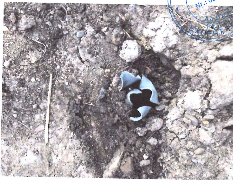
Tub de dren degradat, nefunctional, din zona rampei podului , km 36+100
