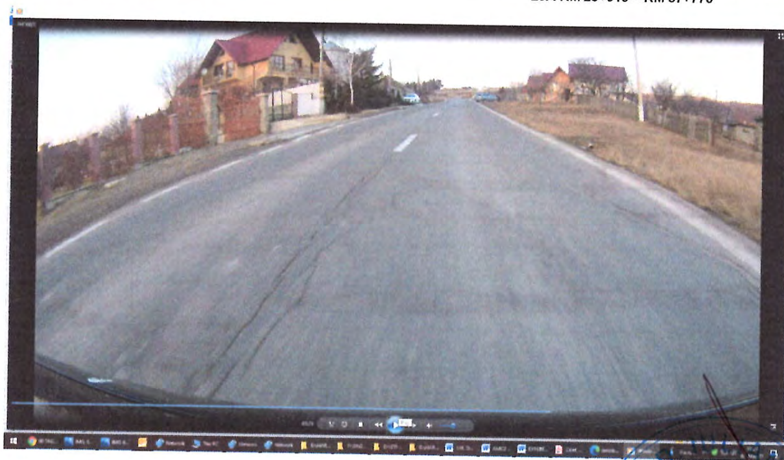
Zona de drum DN29A, cu degradari la nivelul imbracamintii rutiere pe suprafete extinse , gropi, zone cu fisuri si crapaturi pe diverse directii
