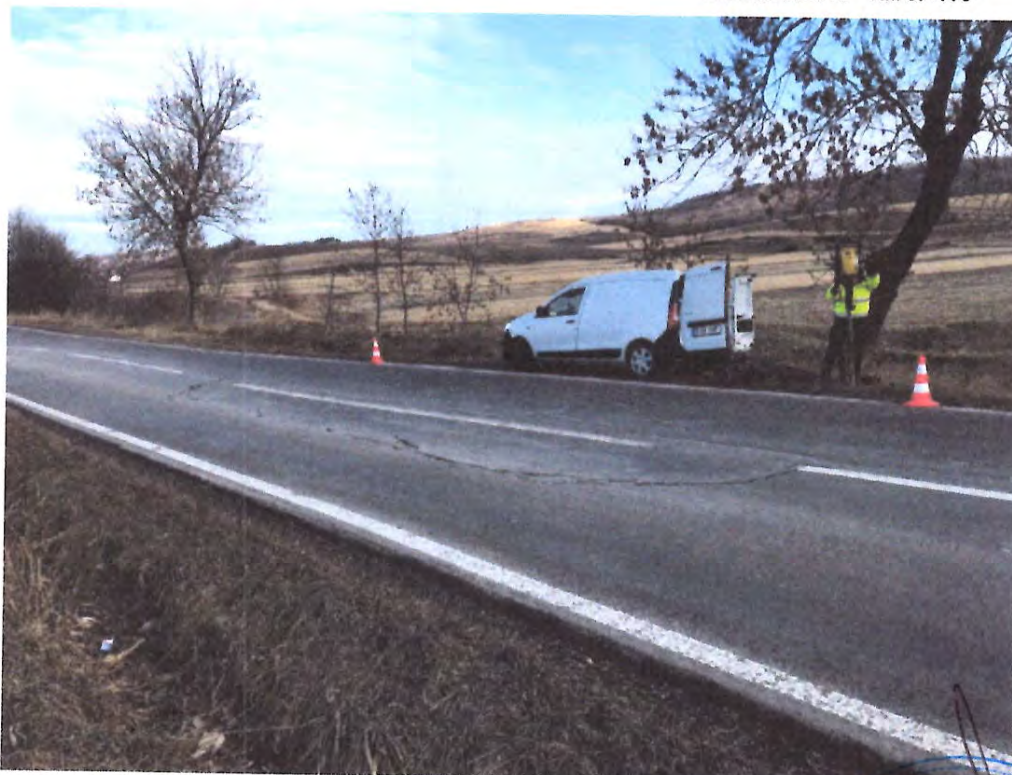
Zona de drum DN29A, zona km 35+200 degradari la nivelul imbracamintii rutiere pe suprafete extinse , gropi, zone cu fisuri si crapaturi pe diverse directii , denivelari longitudinale, tasari ale partii carosabile
