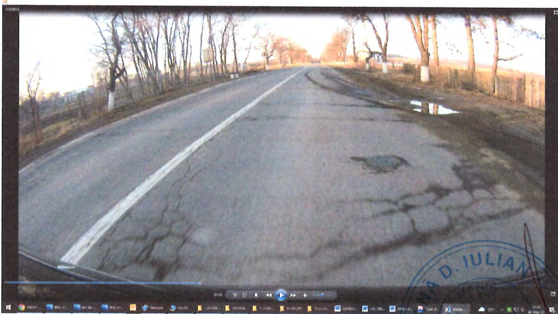
Zona de drum DN29A, , cu degradari la nivelul imbracamintii rutiere, gropi, falantari cu fisuri si crapaturi pe mai multe directii, apa balteste pe acostament, lipsa santuri
