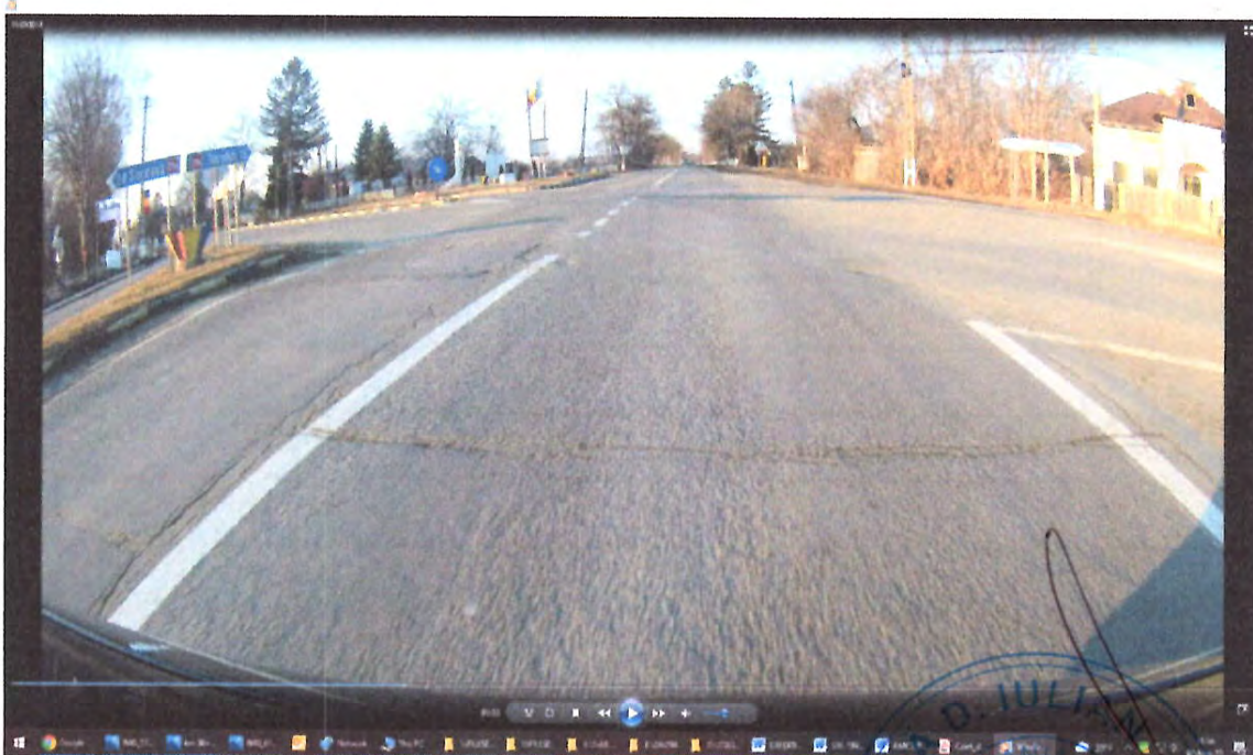
Zona de drum DN29A, zona intersectiei cu DN29C, cu degradari la nivelul imbracamintii rutiere, gropi, cu fisuri si crapaturi pe mai multe directii
