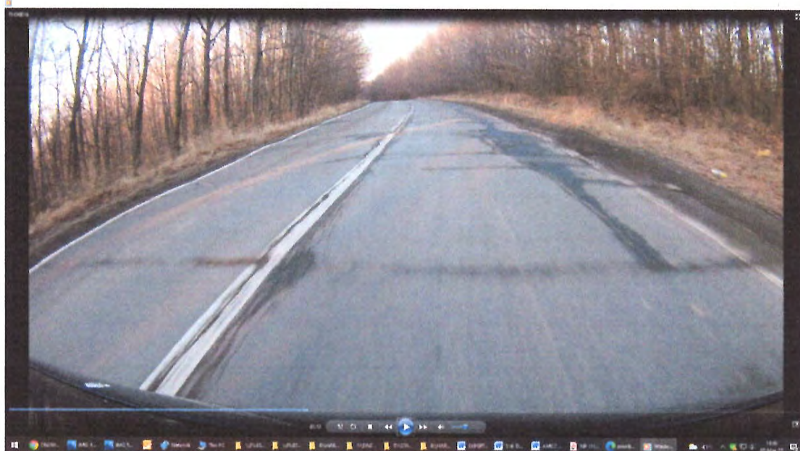
Zona de drum DN29A , cu degradari la nivelul imbracamintii rutiere pe suprafete extinse , gropi, cu fisuri si crapaturi pe mai multe directii, , acostamente degradate, fara santuri
