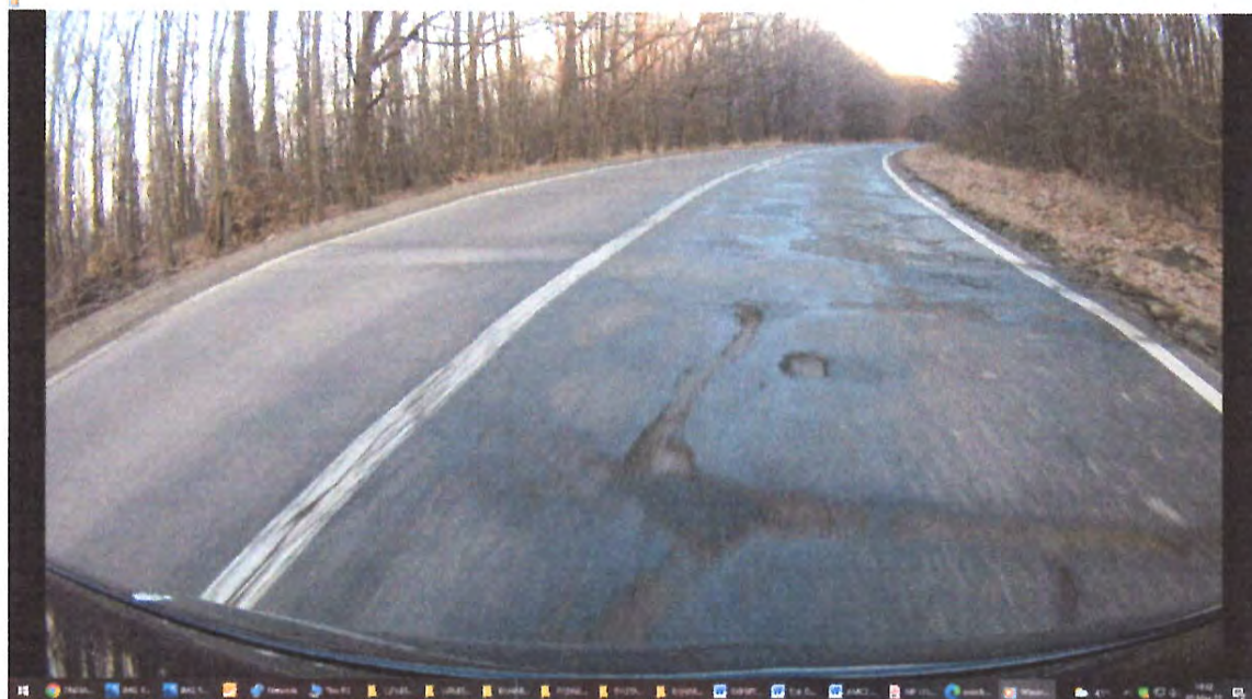
Zona de drum DN29A , zona km 28+000 , cu degradari la nivelul imbracamintii rutiere pe suprafete extinse , gropi, cu fisuri si crapaturi pe mai multe directii, , acostamente degradate, fara santuri
