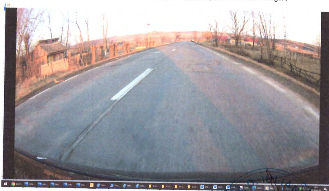
Zona de drum DN29A, degradari la nivelul imbracamintii rutiere pe suprafete extinse , gropi, zone cu fisuri si crapaturi pe diverse directii , zone cu faientari, fara santuri de scurgere
