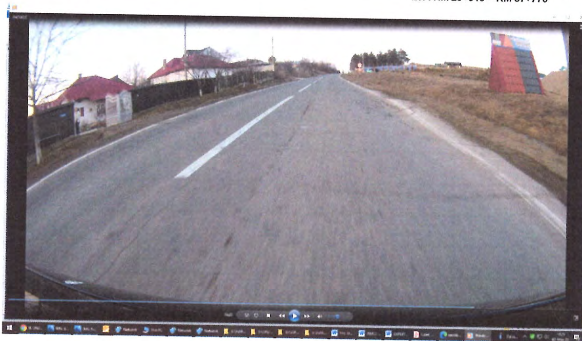
Zona de drum DN29A, zona km 37+100, cu degradari la nivelul imbracamintii rutiere pe suprafete extinse , gropi, zone cu fisuri si crapaturi pe diverse directii , tasari la margine, denivelari
