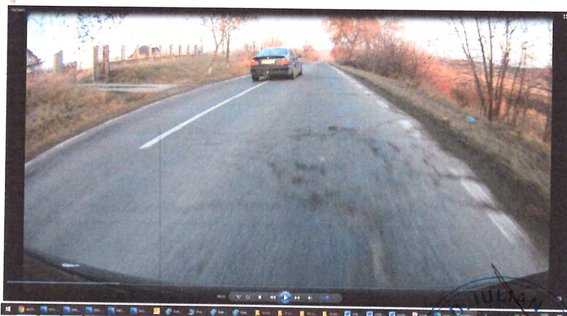
Zona de drum DN29A, , degradari la nivelul imbracamintii rutiere pe suprafete extinse , cu fisuri si crapaturi, zone cu faientari, sant de pamant colmatat
