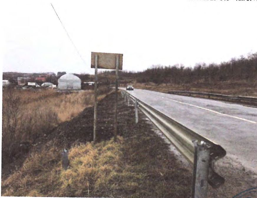
Zona de drum DN29A, zona km 36+100 degradari la nivelul imbracamintii rutiere pe suprafete extinse, cu tasari si denivelari pe rampa podului peste paraul Intors, zona de terasament refacuta necorespunzator
