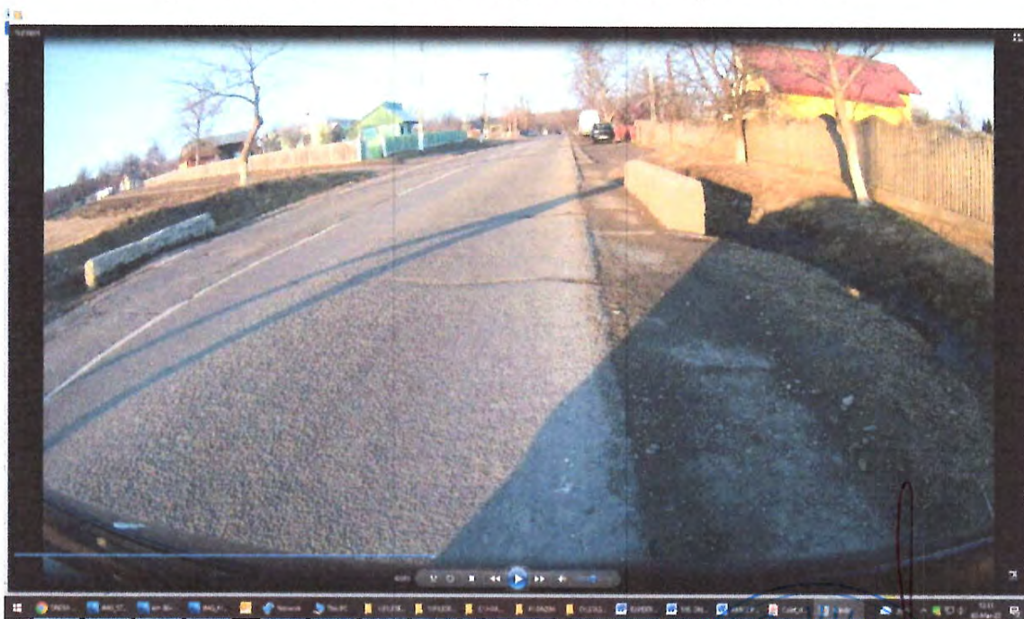
Zona de drum DN29A , cu degradari la nivelul imbracamintii rutiere , cu gropi, faientari , cu fisuri si crapaturi pe mai multe directii , , santuri din pamant colmatate, podet existent colmatat
