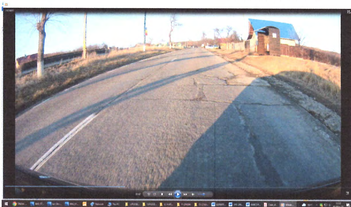
Zona de drum DN29A , cu degradari la nivelul imbracamintii rutiere , cu gropi, faientari , cu fisuri si crapaturi pe mai multe directii,dale din beton sparte, santuri din pamant colmatate
