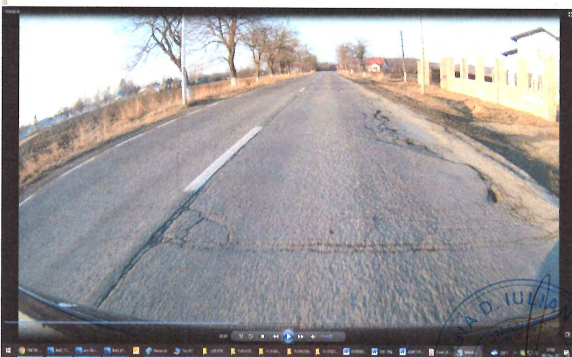
Zona de drum DN29A, , cu degradari la nivelul imbracamintii rutiere,gropi, faiantari, cu fisuri si crapaturi pe mai multe directii, lipsa santuri
