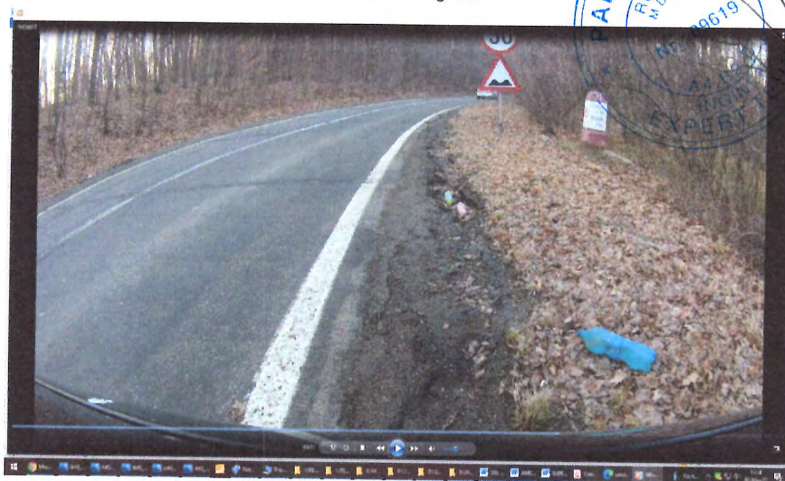
Zona de drum DN29A, zona km 31+000, degradari la nivelul imbracamintii rutiere pe suprafete extinse , gropi, faientari, cu fisuri si crapaturi pe mai multe directii, denivelari, pelada, cu sant din pamant colmatat, acostament degradat
