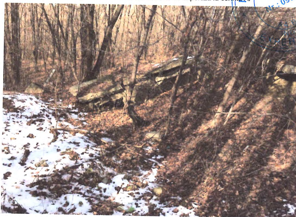
Zona de drum DN29A, zona km 29+950, cu zona de dale de beton pe partea stanga prabusite datorita surparilor produse la corpul terasamentelor, se vor stabili solutii de consolidare conform recomandarilor din studiul geotehnic si solutiilor stabilite de expertiza la cerinta Af
