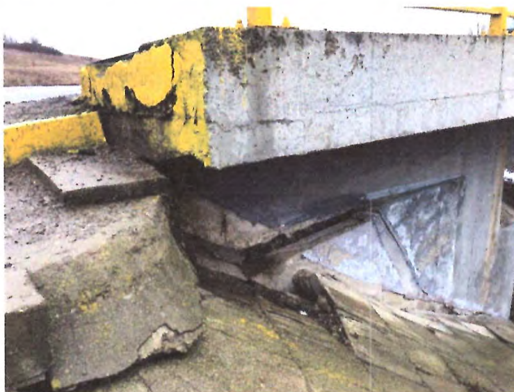
Apariția unor degradări în structura podului, zona sfertului de con;
