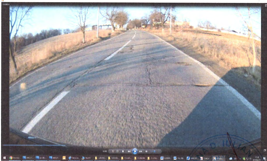
Zona de drum DN29A, sector de inceput cu degradari la nivelul imbracamintii rutiere, gropi, cu fisuri si crapaturi pe mai multe directii
