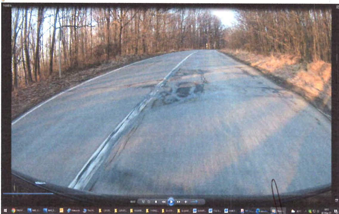
Zona de drum DN29A ,zona km 27+000, cu degradari la nivelul imbracamintii rutiere pe suprafete extinse , gropi, cu fisuri si crapaturi pe mai multe directii,dale din beton sparte, acostamente degradate, santuri existente colmate
