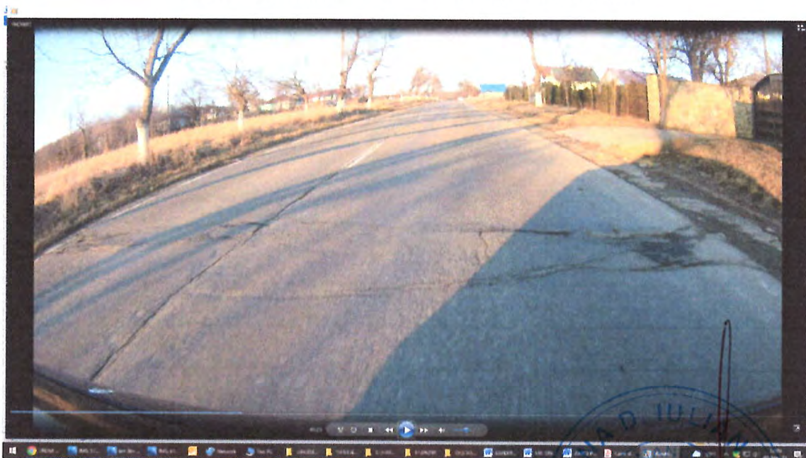
Zona de drum DN29A , cu degradari la nivelul imbracamintii rutiere , cu gropi, faiantari, cu fisuri si crapaturi pe mai multe directii, santuri din pamant colmatate
