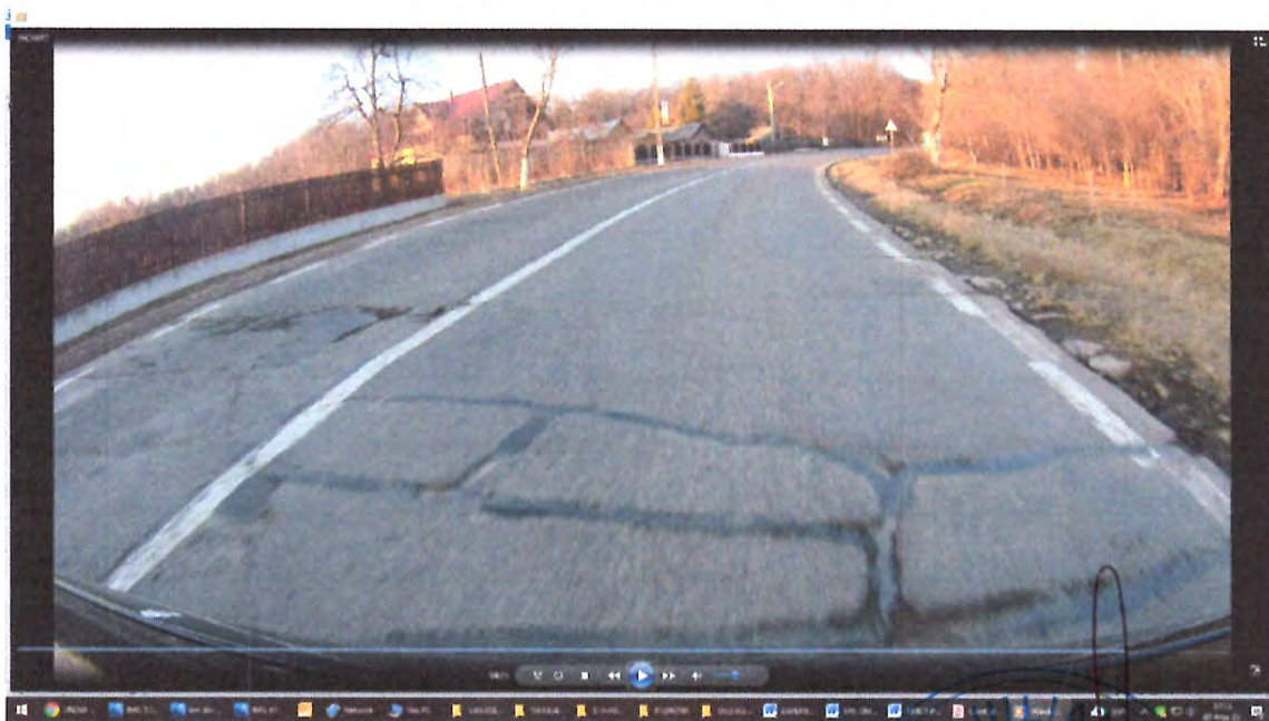
Zona de drum DN29A , cu degradari la nivelul imbracamintii rutiere , cu gropi, faiantari, cu fisuri si crapaturi pe mai multe directii, dale din beton sparte, acostamente degradate, santuri colmate
