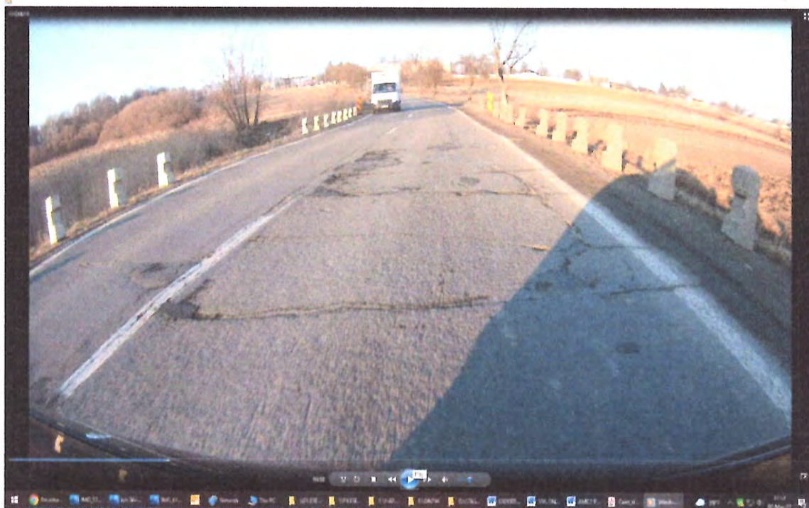
Zona de drum DN29A, sector de inceput cu degradari la nivelul imbracamintii rutiere, gropi, cu fisuri si crapaturi pe mai multe directii, parapet rigid degradat
