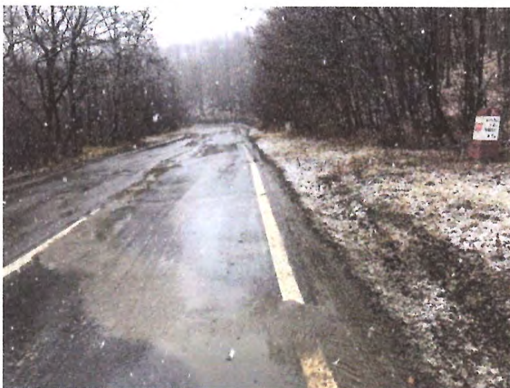
Curgerea necontrolată a apelor din precipitații pe traseul drumului;
